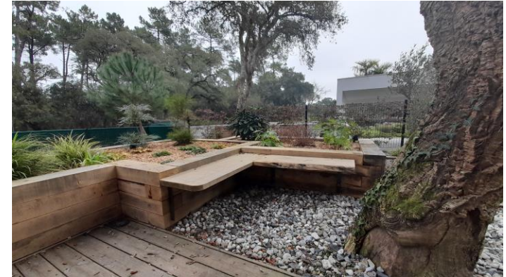
Bordure en poutre de chêne, posée à plat sur 5 étages, pour une hauteur finie de 0,60m. Paillage organique en copeaux de bois
