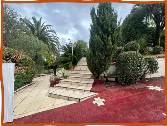
Reprise des derniers emmarchements de l'escalier existant et création d'un palier distribuant la zone piétonne et l'entrée du garage (en enrobé).
